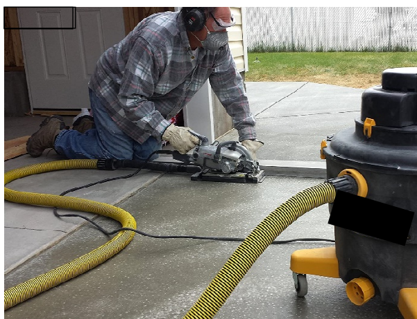
Figura 4 - Protezioni antipolvere per seghe circolari e smerigliatrici
