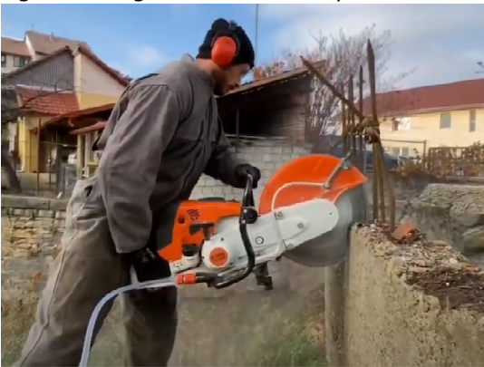
Figura 6 - Seghe circolari ad acqua
