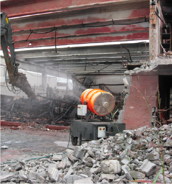
Figura 5 - Sistema di bagnatura in opere di demolizione
